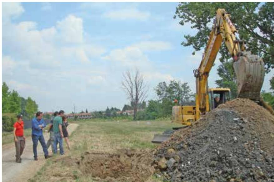
sia laterizi, cocci di piastrelle, ecc..) attraverso scavi (nell'area verde) e carotaggi (nell'area pavimentata della piazza) e il prelievo di acque sotterranee (attraverso la realizzazione di 4 piezometri). Ogni scavo viene chiuso a seguito del prelievo del campione e comunque entro la fine della giornata.
