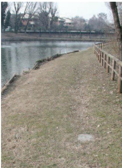
La sponda orientale del laghetto di via Marzabotto stava lentamente, ma in modo inevitabile, scivolando all'interno del bacino con due movimenti: il primo, il più evidente, nella parte di sponda a diretto contatto con lo specchio d'acqua; il secondo, più interno e lento, interessava una parte più importante di terreno. Questo fenomeno complesso si verificava nei primi 40 metri di sponda, mentre negli altri 35 si constatava una forte erosione dovuta
