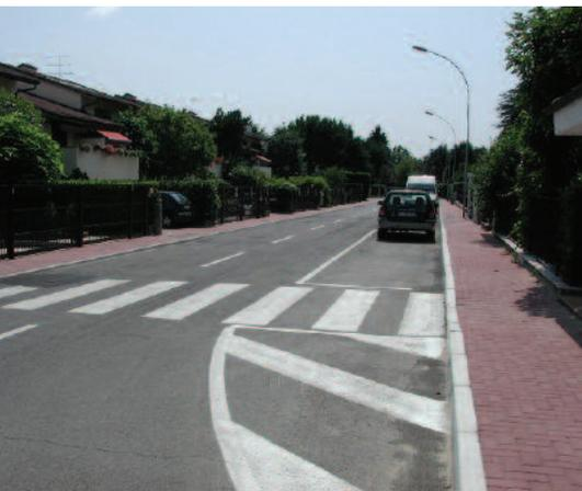
I tracciati sono stati sistemati completamente mediante la realizzazione di un nuovo manto di usura in elementi autobloccanti in doppio strato, di colore rosso.
