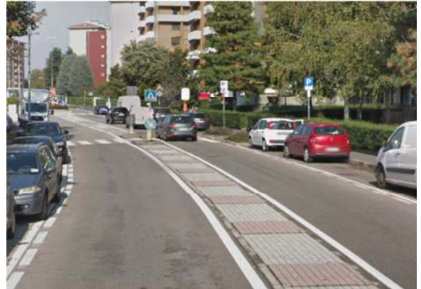
Esempio di parterre centrale semisormontabile, con inserimento delle isole di protezione dell'attraversamento pedonale (Settimo M.)
